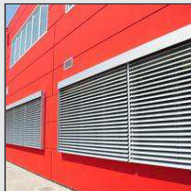
Instalacion cortina exterior
