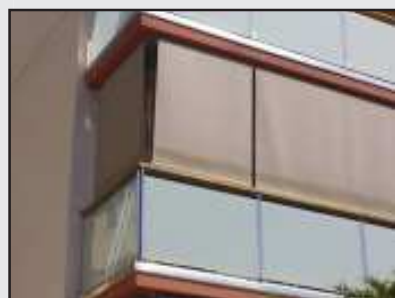
Cortina enrollable con guías traslúcidas Gi3 (Tejido por fuera de la guía)
