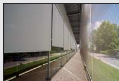
Cortina enrollable con guías traslúcidas Gv4 (Tejido por fuera de la guía)
